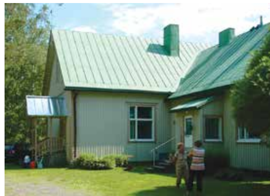
Paljakan koulu kunnostettuna nyt. Rakennus on Paljakka-Pökölä kyläyhdistyksen omistama Palko-talo.
